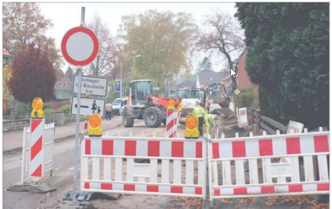
Selbst Anlieger werden ihre Grundstücke an der Bordenauer Straße nur noch aus einer Richtung erreichen können - eine Durchfahrt ist nicht mehr gegeben. Foto: Seitz (Archiv).
